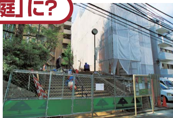
右仮囲いがホテルの改修工事、左階段上が神泉公園
