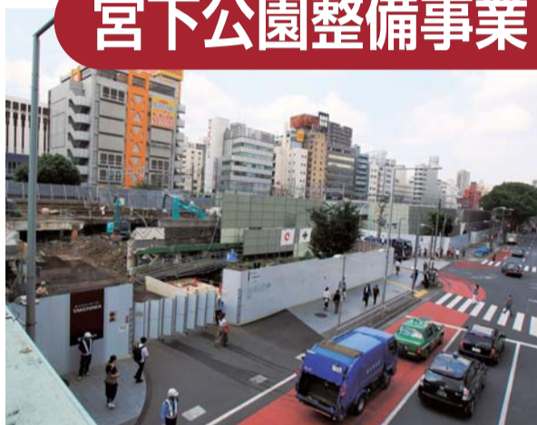
基礎工事中の宮下公園
