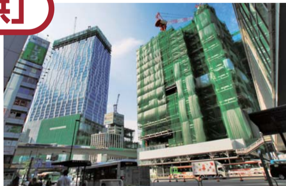
高層ビルが林立する渋谷駅前の再開発工事
